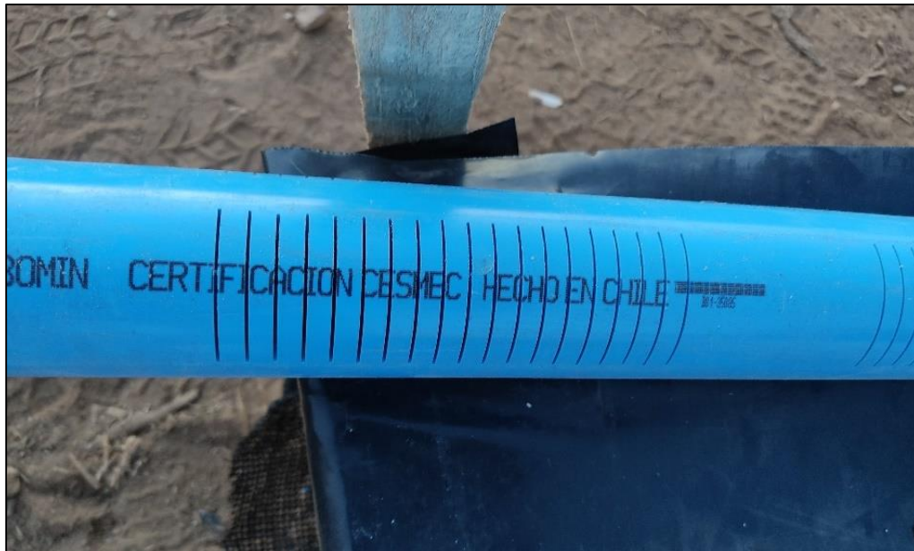
Figura 4-3: Tubería instalada ranurada con láser de fábrica slot 40
