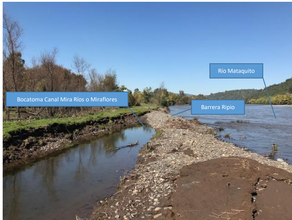
Figura 1. Vista Bocatoma desde la ribera derecha del Río Mataquito.
