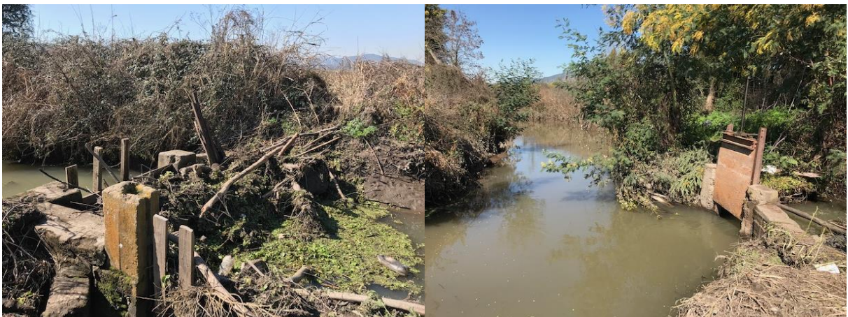
Figura N° 3. Punto de entrega de aguas en compuerta Fundo El Carmelo.
