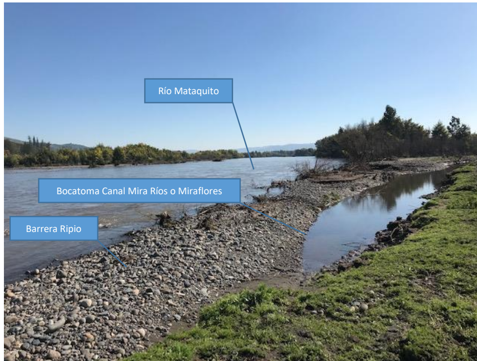
Figura N° 2. Vista Bocatoma desde la ribera derecha del Río Mataquito.
