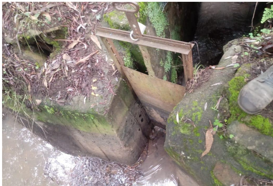
Figura 7. Compuerta canal derivado El Litre.
