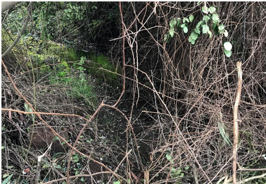
Figura 9. Compuerta final y derrame a predio forestal.
