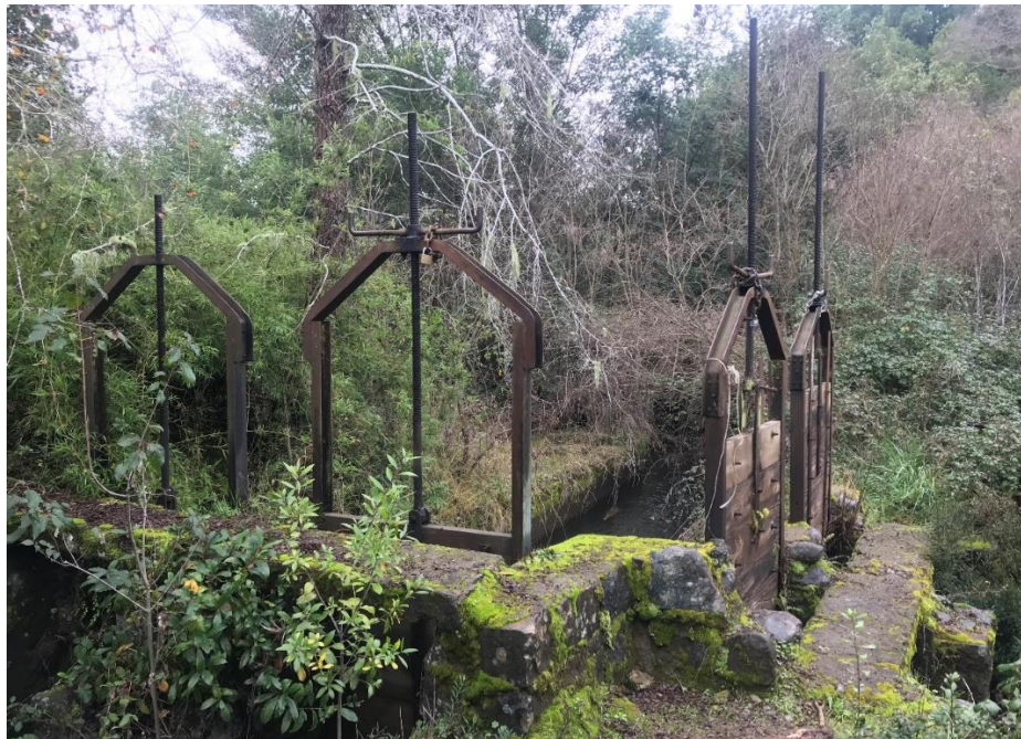
Figura 3. Compuerta de descarga al río Putagán (a la derecha de la imagen) y compuerta reguladora (a la izquierda de la imagen).
