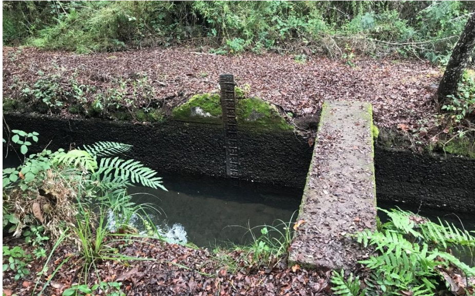
Figura 4. Sección de Aforo
