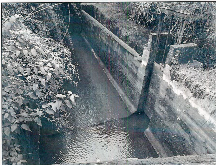
Imagen 4. Bocatoma del canal Chufquén con doble compuerta (vista frontal desde el canal).
