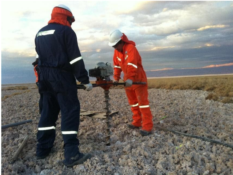
Figura 3-3: Perforación de punteras en el borde sur del Salar de Atacama.
