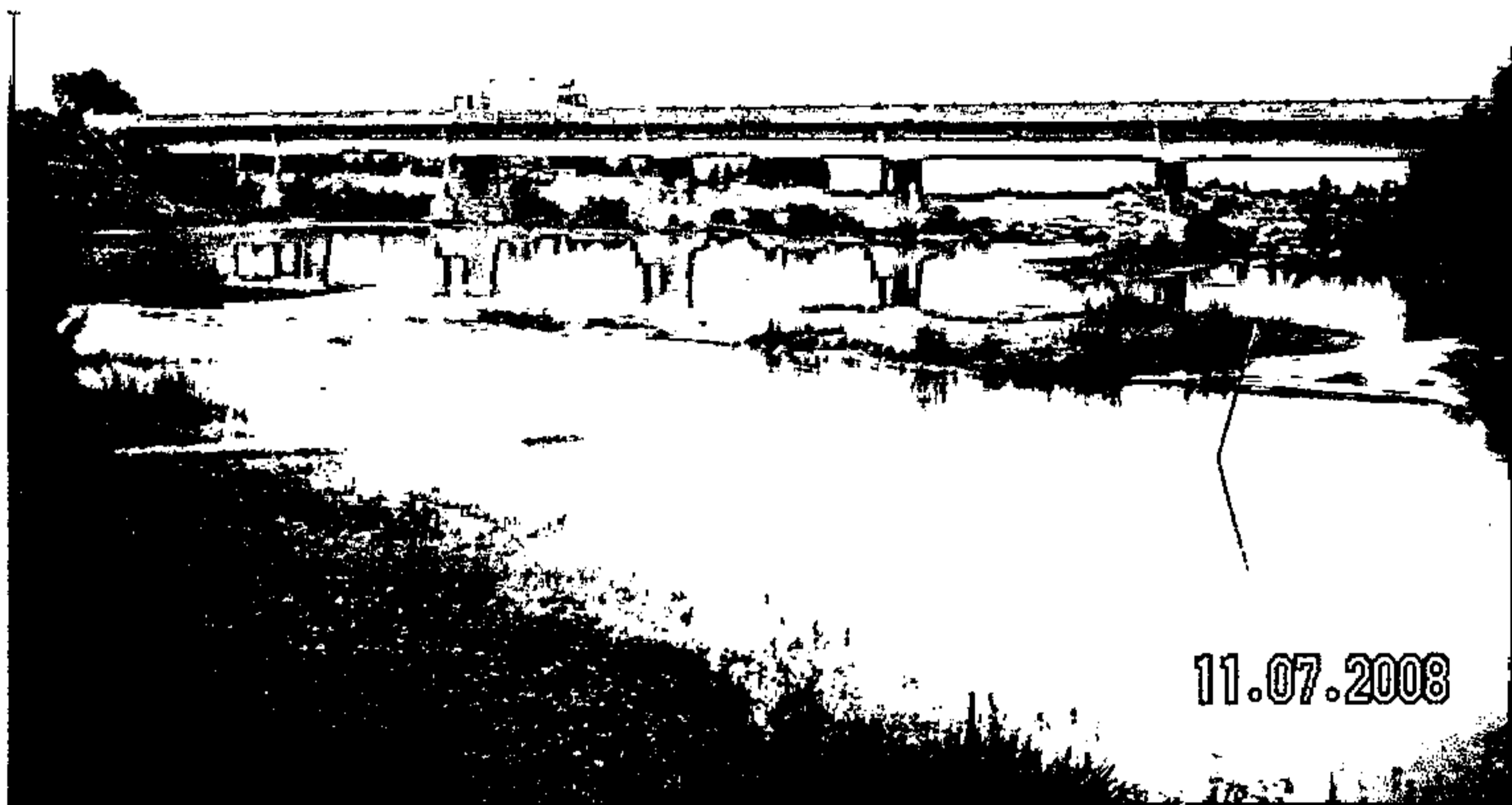
Fotografía F.4- Puente Fiscal
