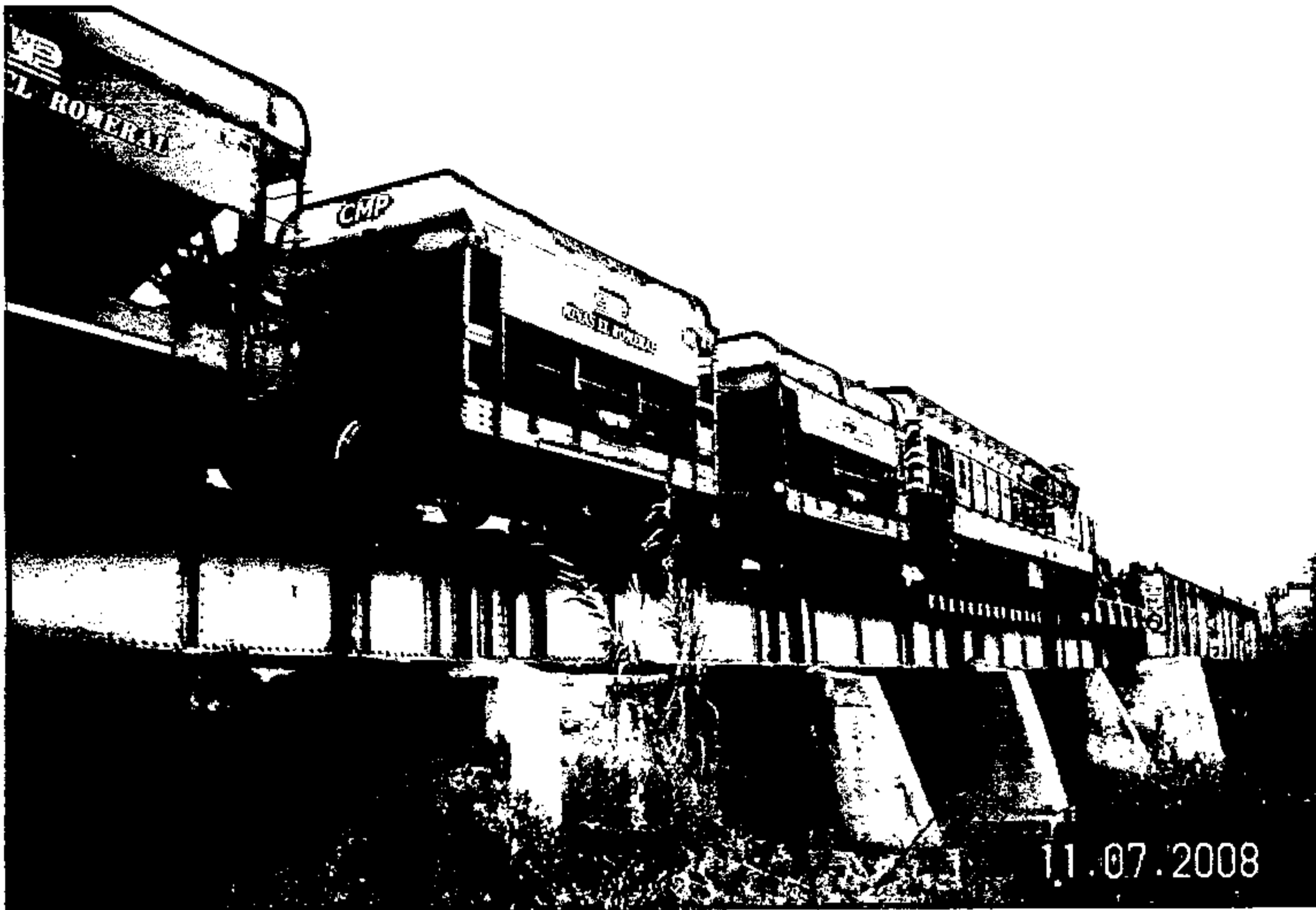
Fotografía F.3 - Puente Ferroviario CMP
