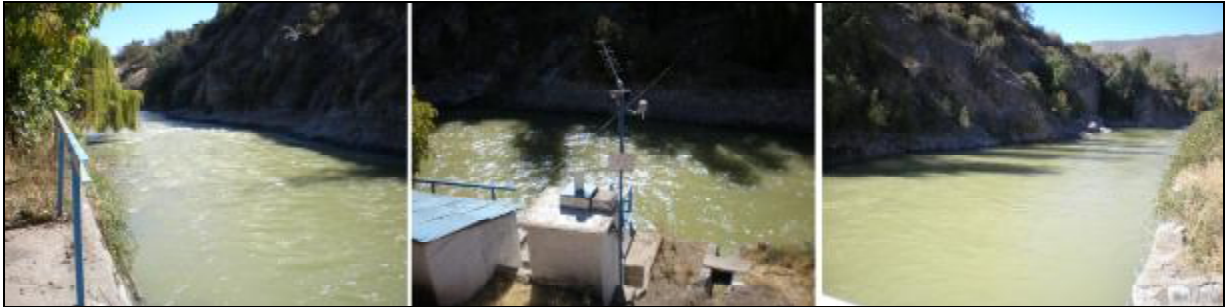
Figura 9.1. (Centro) Estación fluviométrica y meteorológica Aconcagua en Chacabucuito. (Izq.) Vista aguas abajo. (Der.) Vista aguas arriba.
