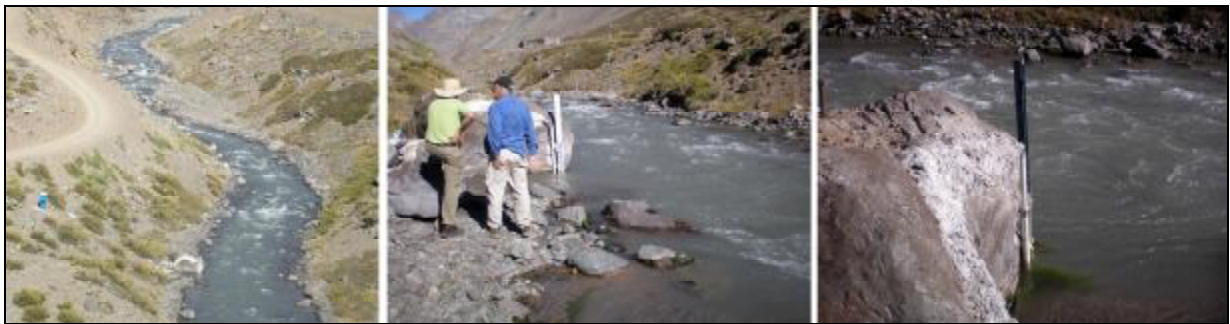
Figura 9.5. (Izq.) Vista panorámica estación fluviométrica Juncal en Juncal. (Centro) Vista aguas arriba. (Der.) Regla limnimétrica y sensor de presión con problemas de embanque.
