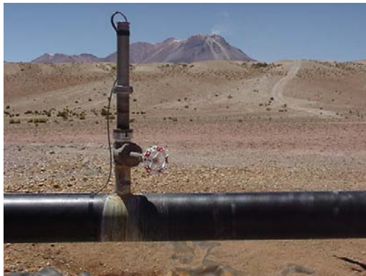
Ilustración 4-2 Medidores de Inserción
