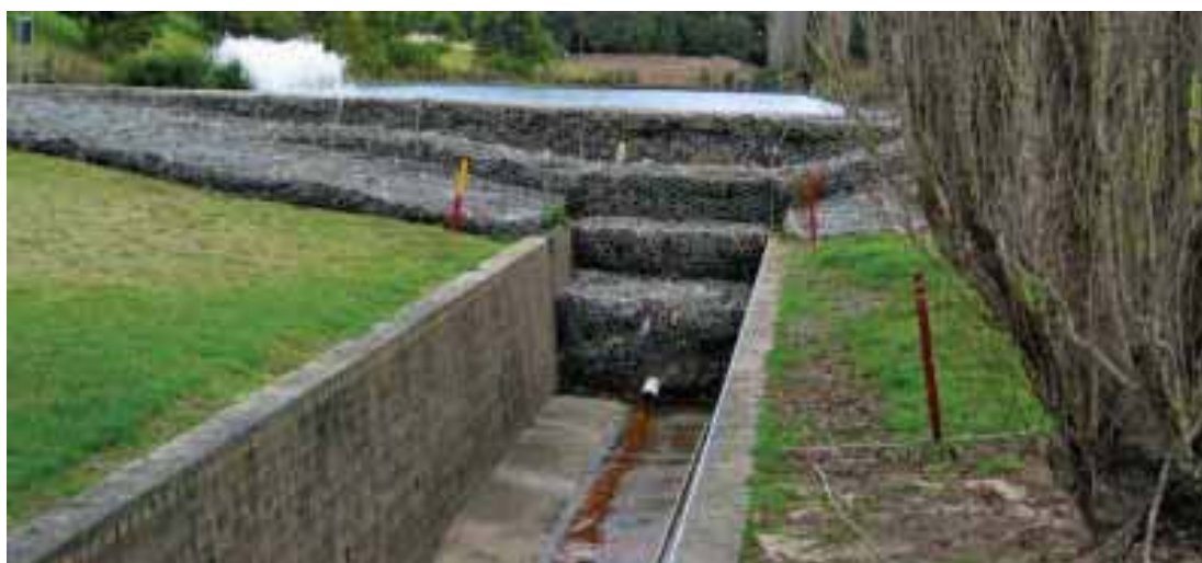
ILUSTRACIÓN 10 - CANALES DE AGUAS LLUVIAS EN BAXLEY
