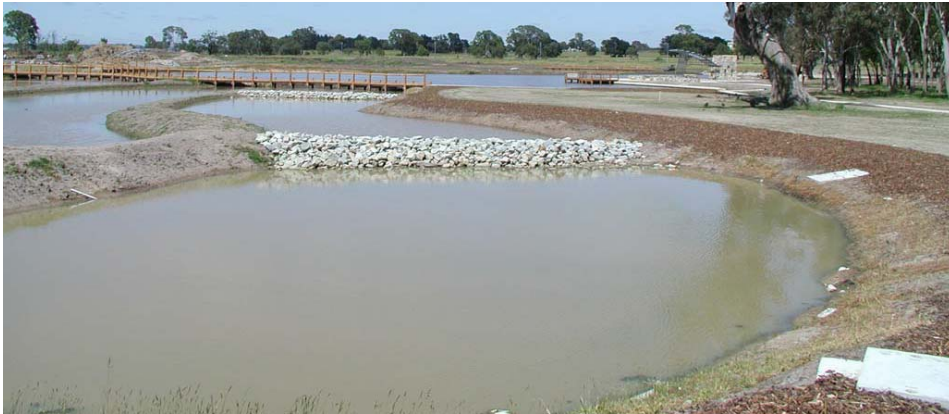
ILUSTRACIÓN 7 – INFRAESTRUCTURA DE MANEJO DE AGUAS PLUVIALES
