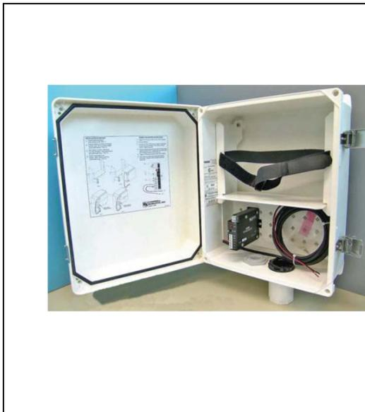
Figura A-3: Caja del PS24, junto al regulador CH100, cables de poder y el soporte de batería. Esta última debe ser instalada por el usuario.
