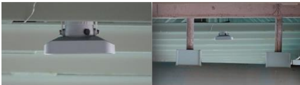
Figura 4.3. Radar RLS, anclado a la estructura metálica del puente.
