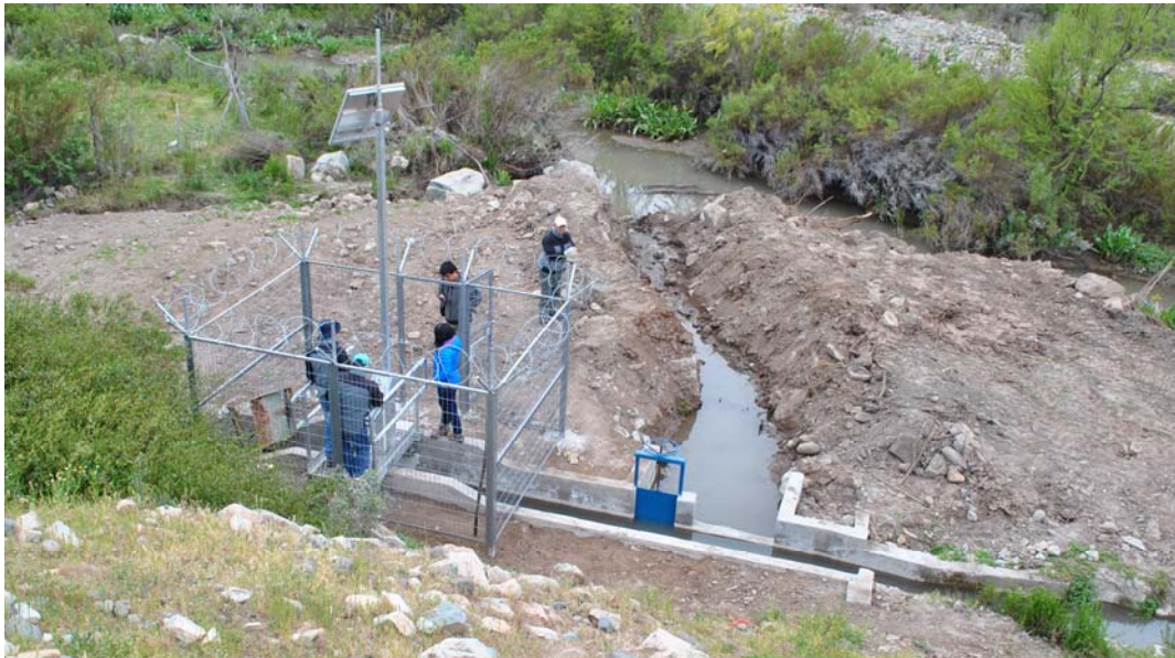
Foto 3.2 Sistemas de Medición en Canales del Río Choapa
