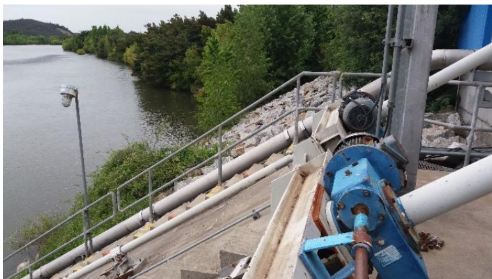
Fotografía 13. Bocatoma Celulosa Arauco.
