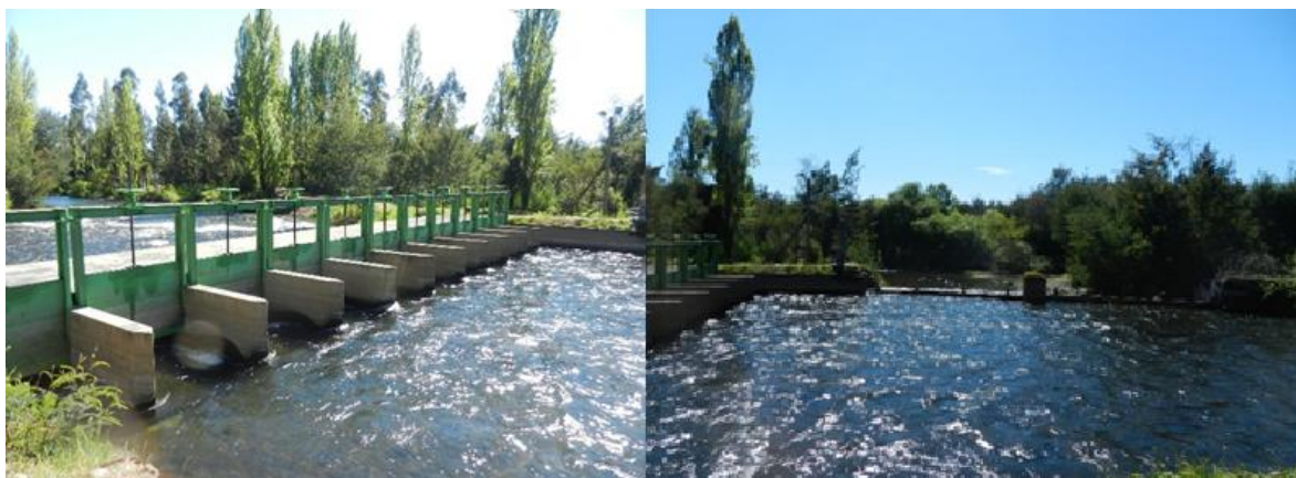
Fotografía 12. Bocatoma canal Zañartu.
