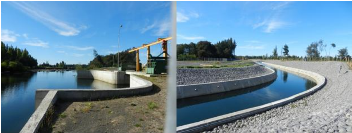
Fotografía 17. Bocatoma de Eléctrica Puntilla.
