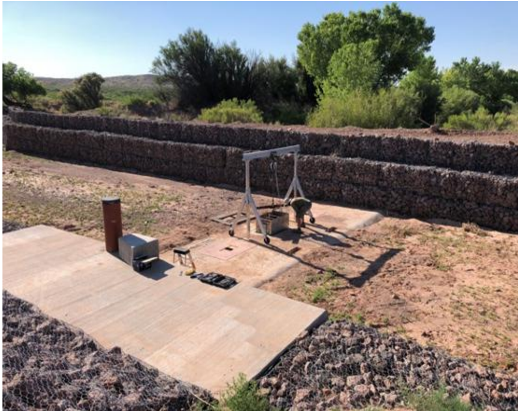
Figura 13. Instalación de trampas de sedimentos en el estero los Piños, Nuevo México, EEUU. (Gentileza del Profesor Jonathan Laronne, 2019).
