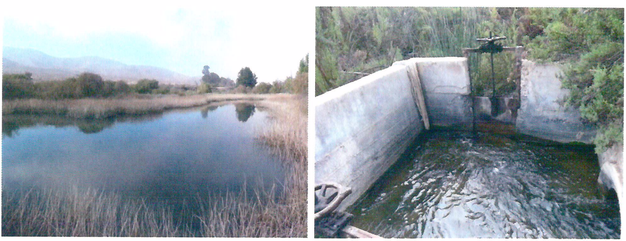
Fotografías N°s. 5 y 6. Tranque del Predio Hacienda Las Ventanas.
