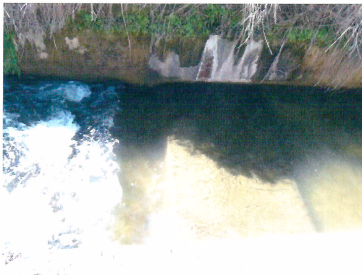
Fotografía N° 4. Vertedero Canal Ventanas.
