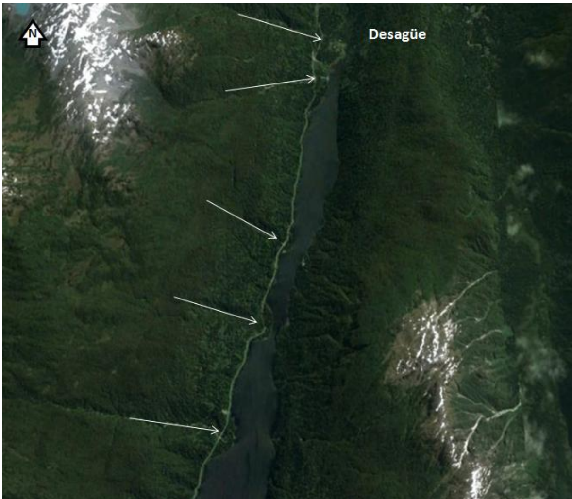
Figura 6. Evidencia de deslizamientos en el Lago Risopatrón.
